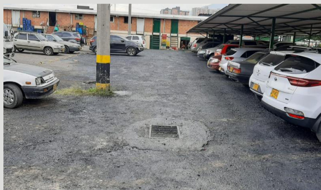
Repavimentación de parqueaderos
