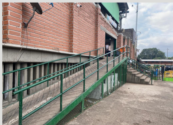
Construcción rampa en puerta N° 07
