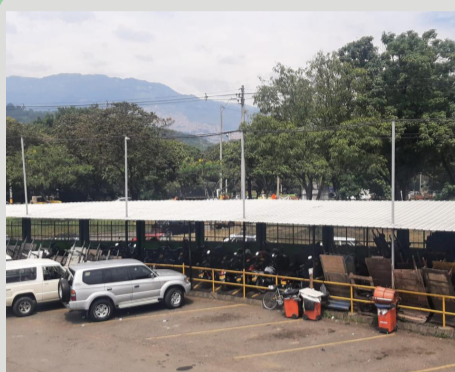
Cubierta nuevo parqueadero de motos Santa Elena
