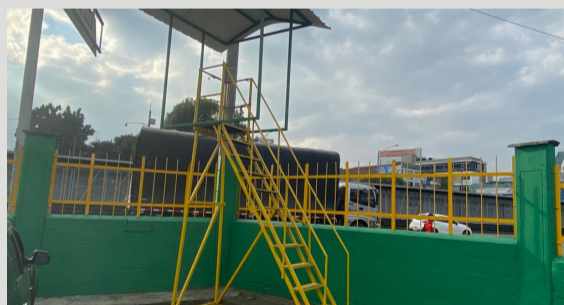
Construcción de garita para parqueaderos
