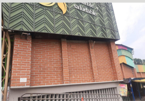
Mantenimiento de fachada
