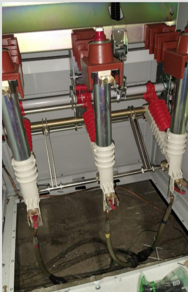
Cambio de seccionadores subestación N°. 01
