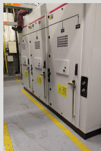
Cambio de acometida 13.200kv
