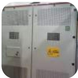
**Subestación No.1**, abastece a los sectores: Carnicerías, Pesqueras, zonas comunes (sector 1). Cambio de transformado de 500 KVA, en aceite por trasformador de 500 KVA en seco y en resina marca Rimiel, adicionalmente se cambió el ML y seccionador. **Inversión: \$301.765.062 (Trecientos un millón setecientos sesenta y cinco mil sesenta y dos pesos).**
